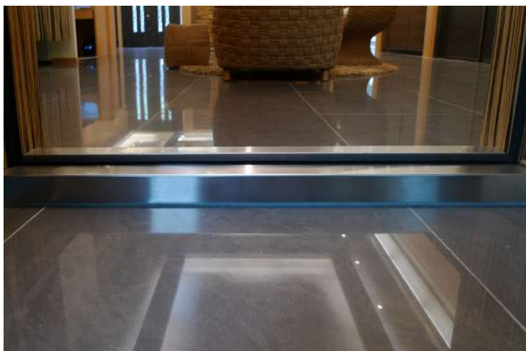
▲ 不鏽鋼門檻內側
